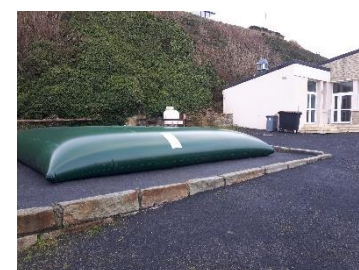
Réserve incendie de 60 m³ réalisée fin 2017 sur l'esplanade de la salle des fêtes.
